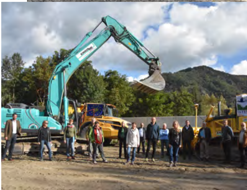
Spatenstich in der Pritzenau © viadonau
